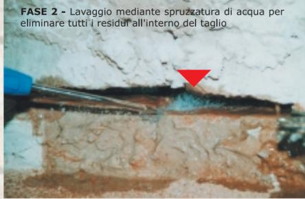
**FASE 2** - Lavaggio mediante spruzzatura di acqua per eliminare tutti i residui all'interno del taglio.
