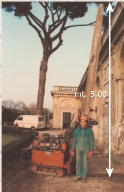
Macchina taglia-muro per interventi fino a mt 5 di spessore di muratura.
