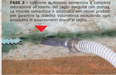
**FASE 3** - Iniezione di miscela cementizia a completa saturazione all'interno del taglio eseguita con pompa. La miscela cementizia è additivata con idonei prodotti per garantire la stabilità volumetrica escludendo ogni possibilità di assestamenti dovuti al taglio.
