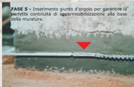
**FASE 5** - Inserimento giunto d'angolo per garantire la perfetta continuità di impermeabilizzazione alla base della muratura.
