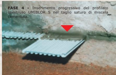
**FASE 4** - Inserimento progressivo del profilato coestruso UMIBLOK S nel taglio saturo di miscela cementizia.
