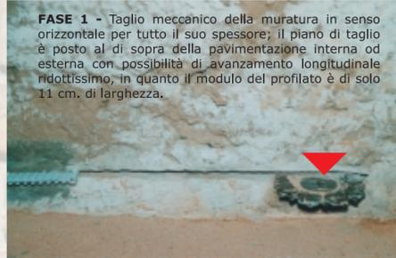
**FASE 1** - Taglio meccanico della muratura in senso orizzontale per tutto il suo spessore; il piano di taglio è posto al di sopra della pavimentazione interna od esterna con possibilità di avanzamento longitudinale ridottissimo, in quanto il modulo del profilato è di solo 11 cm. di larghezza.
